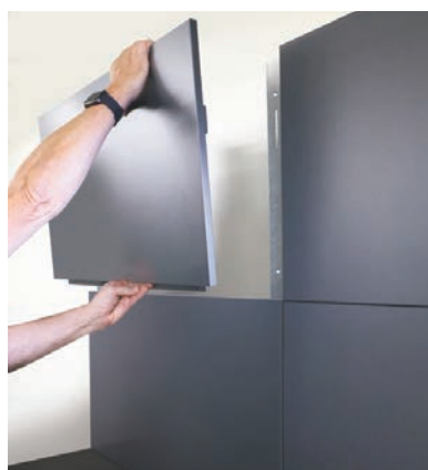
Achterpanelen worden aan het rugriemsysteem bevestigd
