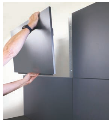
Rückwände werden auf das vertikale Trägersystem aufgesteckt
