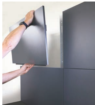
Rückwände werden auf das vertikale Trägersystem aufgesteckt
